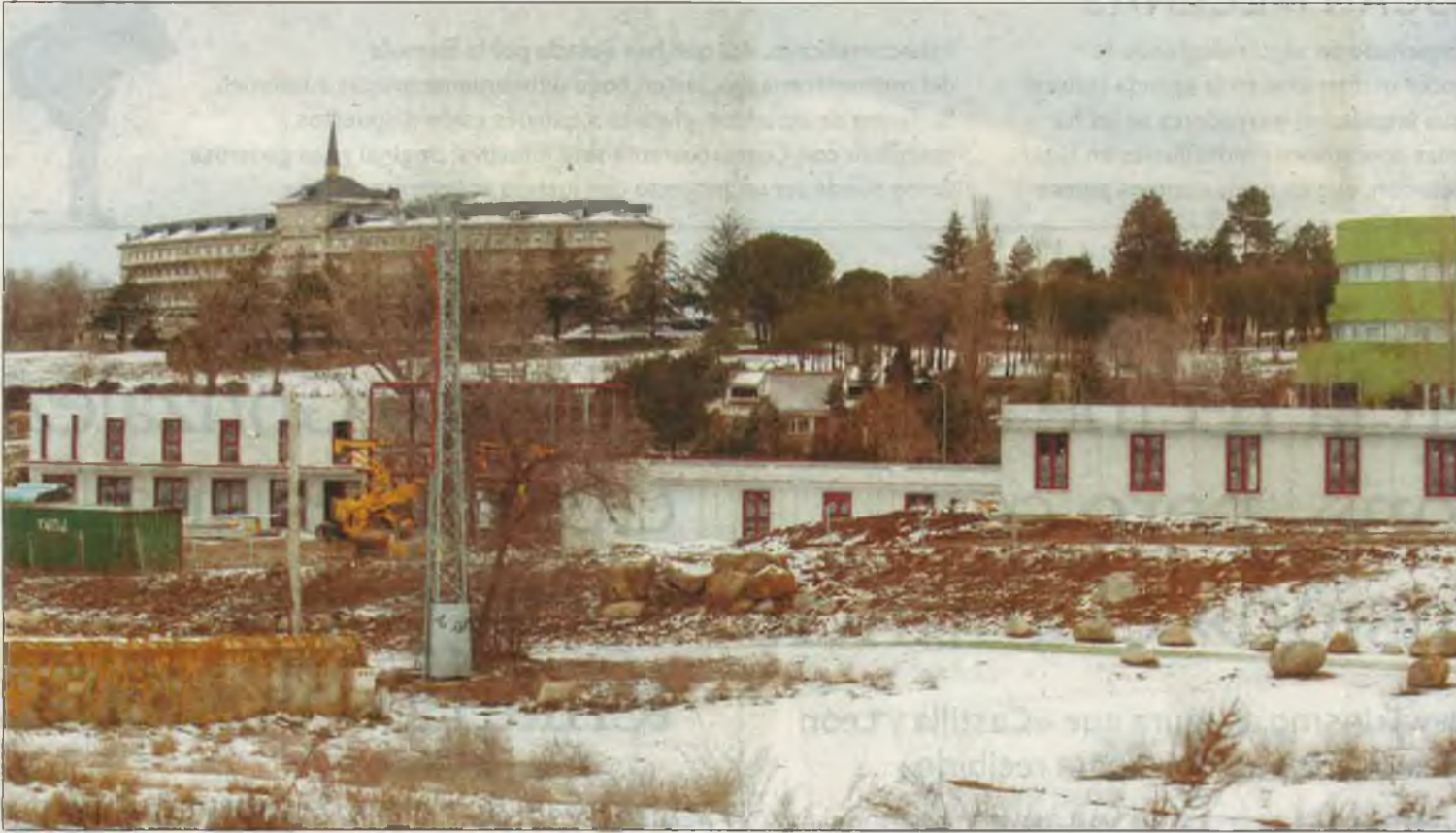
Vista de la construcción de los edificios del albergue. / DAVID CASTRO
