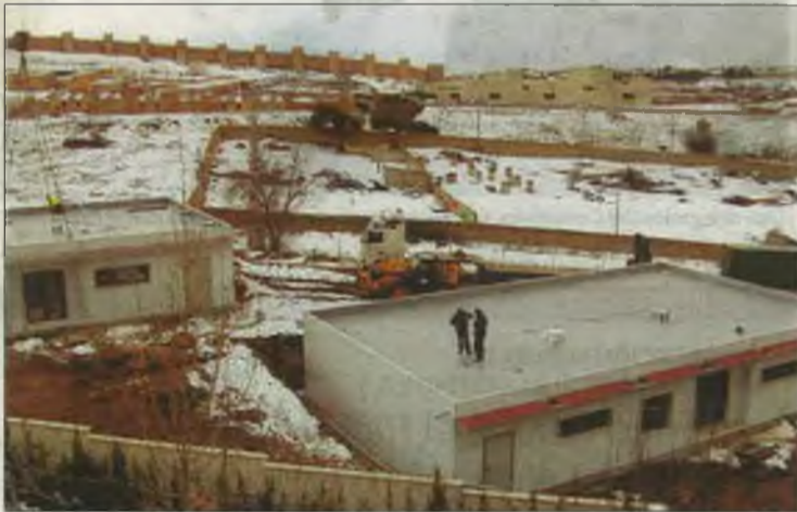
Colocación de los dos edificios.
